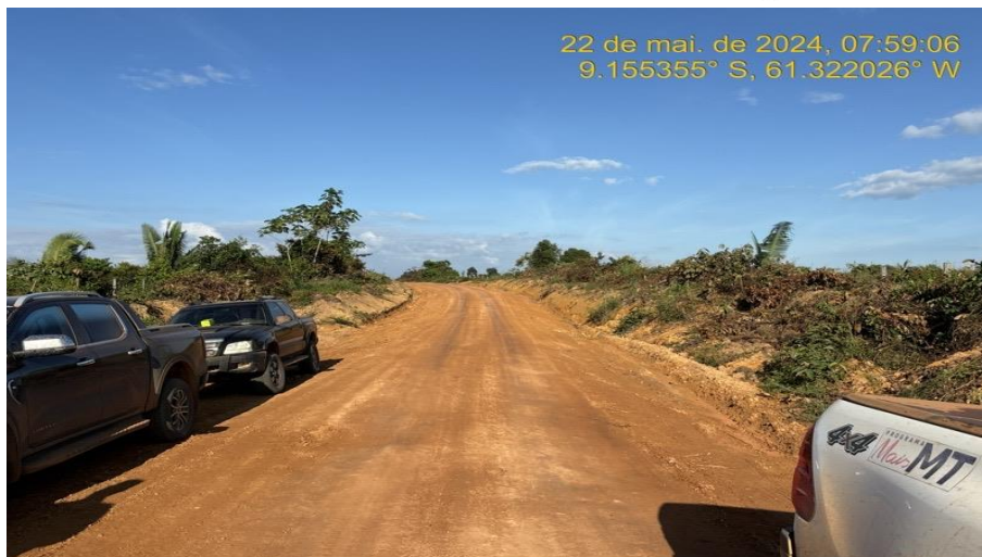
Serviços de Recomposição do Revestimento Primário (encascalhamento), valeta de drenagem e saída d'água.
