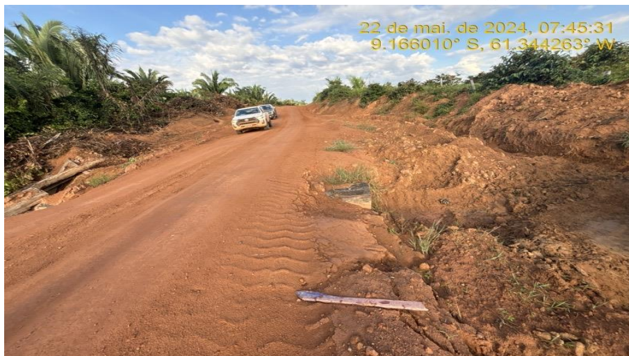
Serviços de Recomposição do Revestimento Primário (encascalhamento), saída d'água, valeta de corte e bueiro de madeira.
