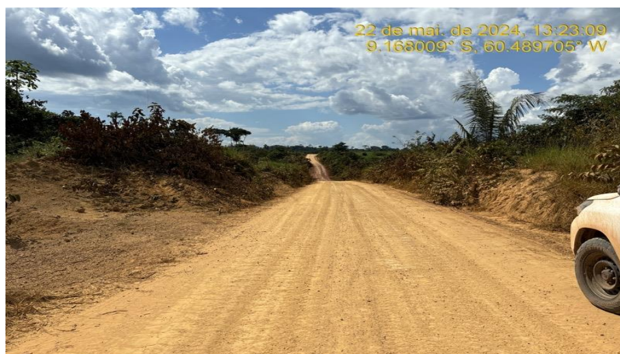
Serviços de Reconformação da plataforma (patrolamento).
