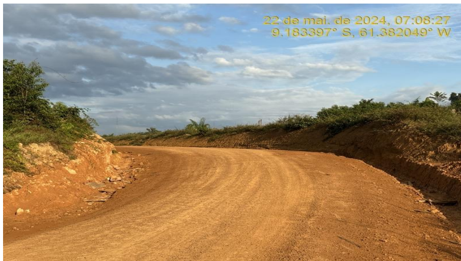
Serviços de Recomposição do Revestimento Primário (Cascalhamento) e valeta de corte.
