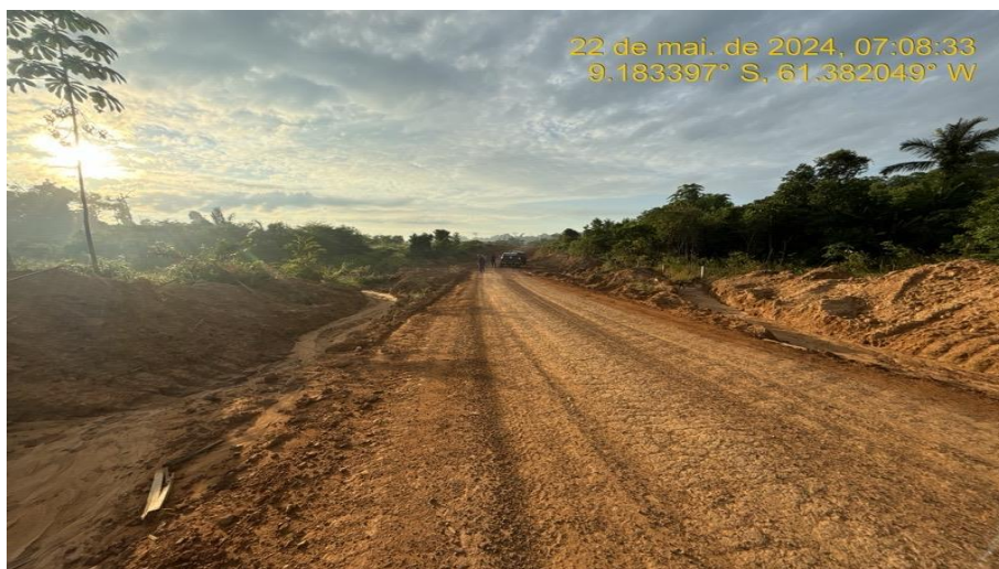
Serviços de Recomposição do Revestimento Primário (encascalhamento) e saída d'água (bigode).
