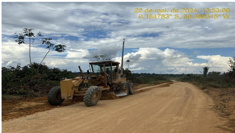
Serviços de Reconformação da plataforma (patrolamento).
