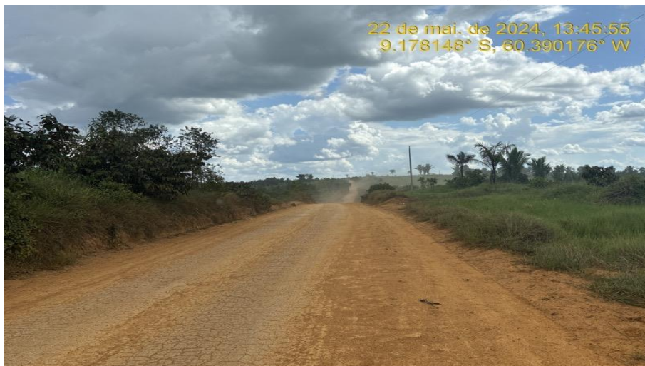
Serviços de Reconformação da plataforma (patrolamento).
