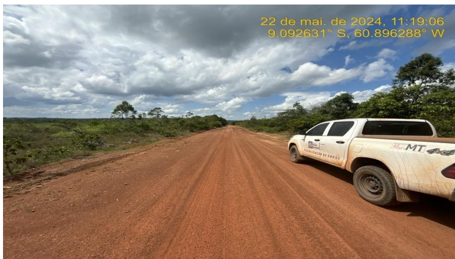
Serviços de Recomposição do Revestimento Primário (encascalhamento).
