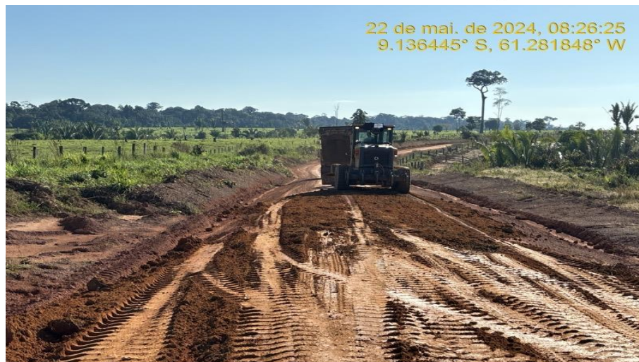
Serviços de Recomposição do Revestimento Primário (encascalhamento).
