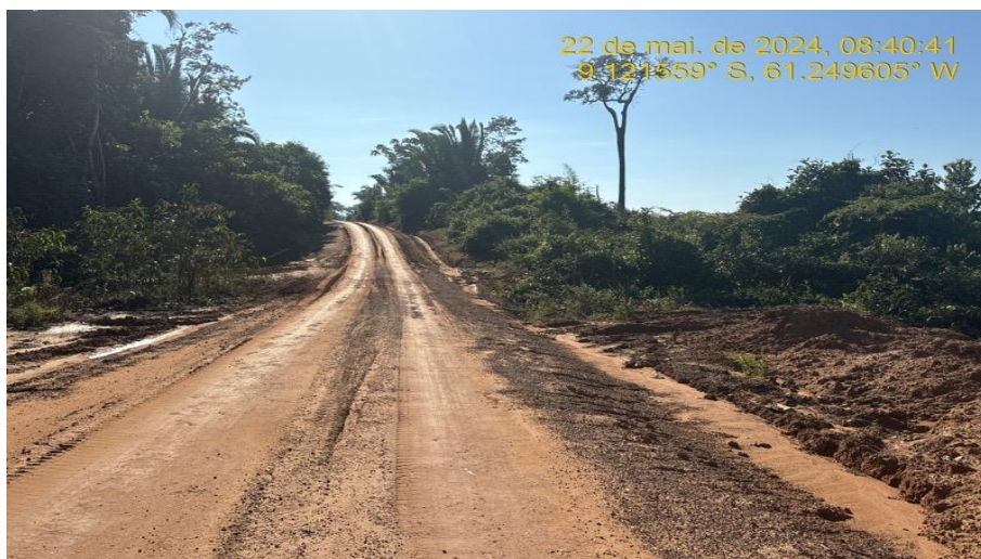
Serviços de Recomposição do Revestimento Primário (encascalhamento), e saída d'água.
