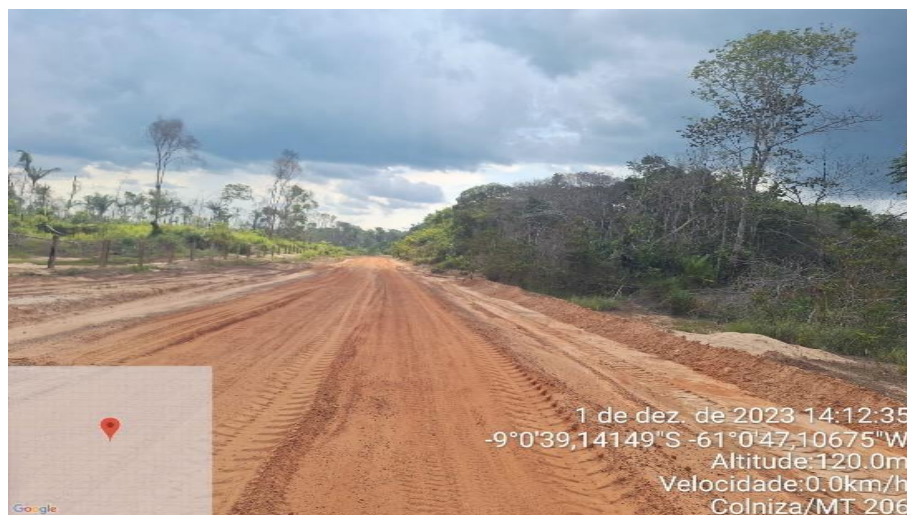
Serviços de Reconformação da plataforma – Fotos fornecidas pela Associação Três Fronteira.
