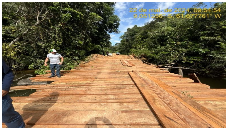
Serviços de Reforma de ponte de madeira (em execução).
