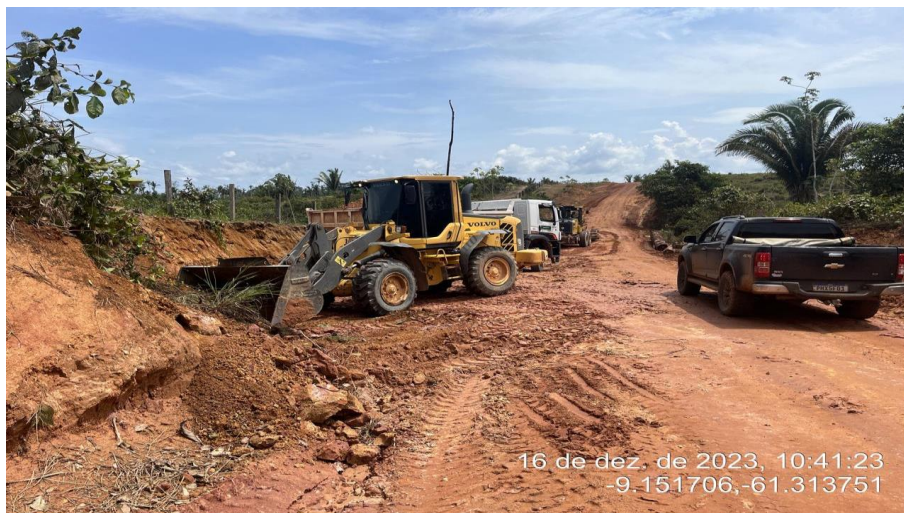
Serviços de Escavação, carga e transporte mat. 1ª cat., Corte de talude – Fotos fornecidas pela Associação Três Fronteira.
