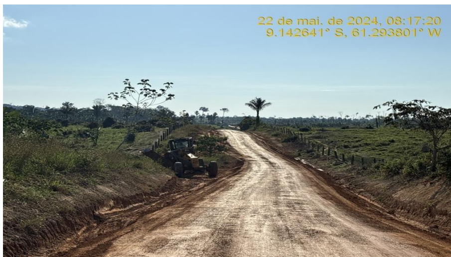
Serviços de limpeza de saída d'água, e Recomposição do Revestimento Primário (encascalhamento).
