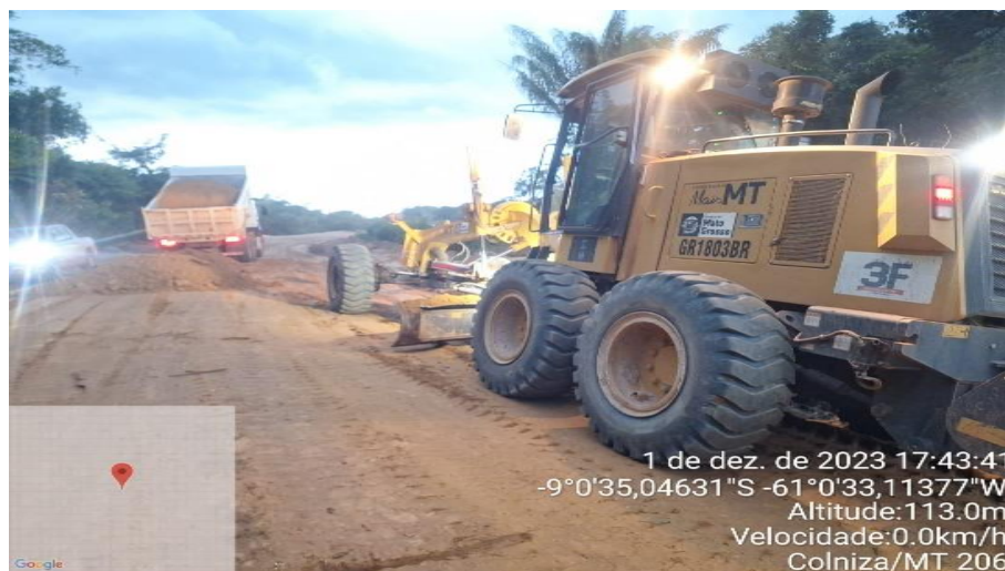
Serviços de Reconformação da plataforma, Recomposição de revestimento primário c/mat. Jaz. (Encascalhamento) – Fotos fornecidas pela Associação Três Fronteira.
