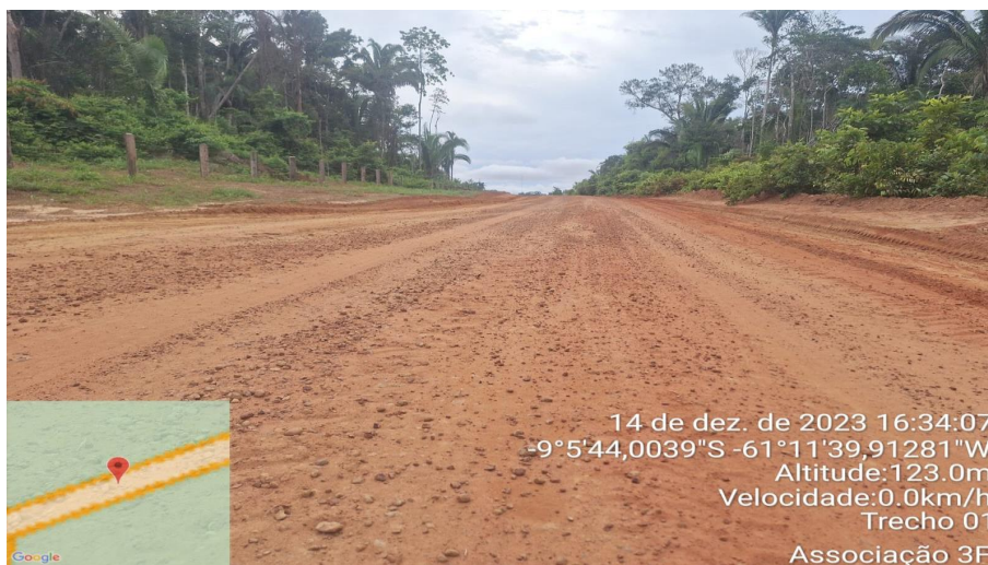
Serviços de Recomposição de revestimento primário c/ mat. jazida – Fotos fornecidas pela Associação Três Fronteira.
