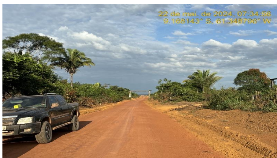
Serviços de Recomposição do Revestimento Primário (encascalhamento).
