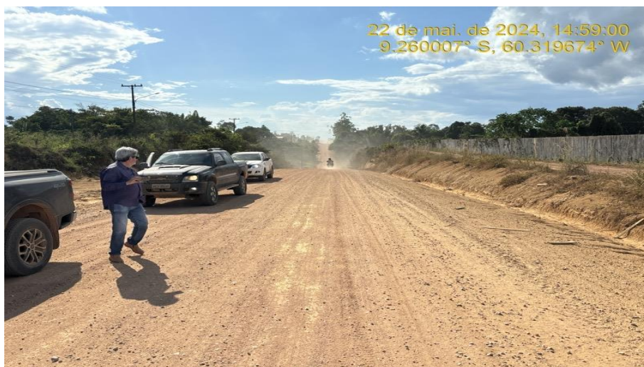
Serviços de Serviços de Recomposição do Revestimento Primário (encascalhamento).
