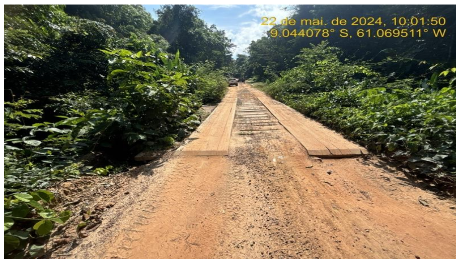
Serviços de Reforma de ponte de madeira (troca de rodeiro e assoalho).
