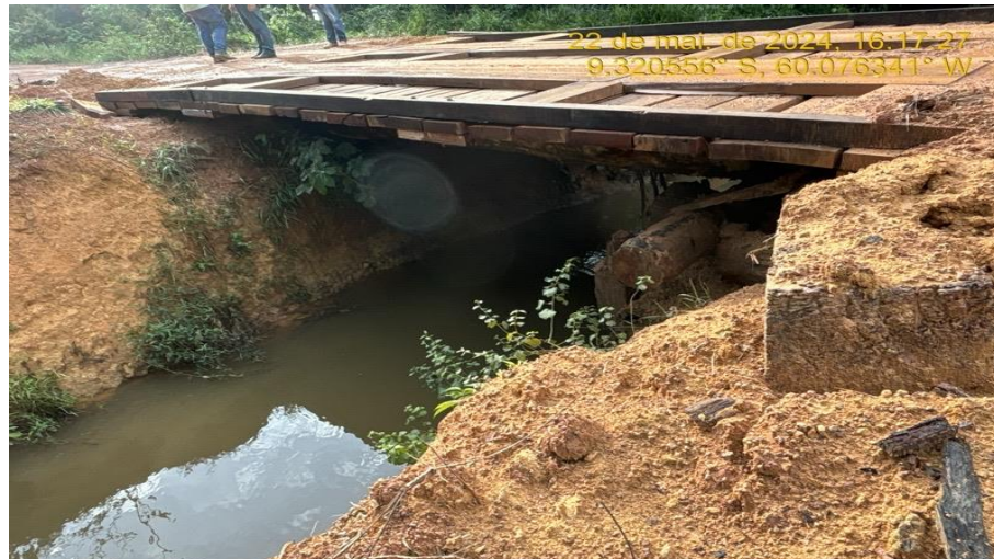
Serviços de Reforma de ponte de madeira (troca de rodeiro, assoalho, trave de rodeiro e guarda rodas), início do trecho km 121,00.
