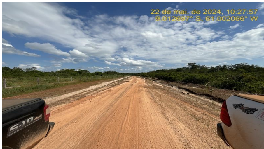
Serviços de Serviços de Recomposição do Revestimento Primário (encascalhamento), e saída d'água.
