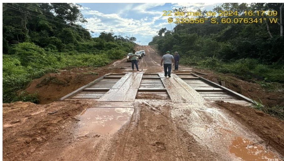
Serviços de Reforma de ponte de madeira (troca de rodeiro, assoalho, trave de rodeiro e guarda rodas), início do trecho km 121,00.
