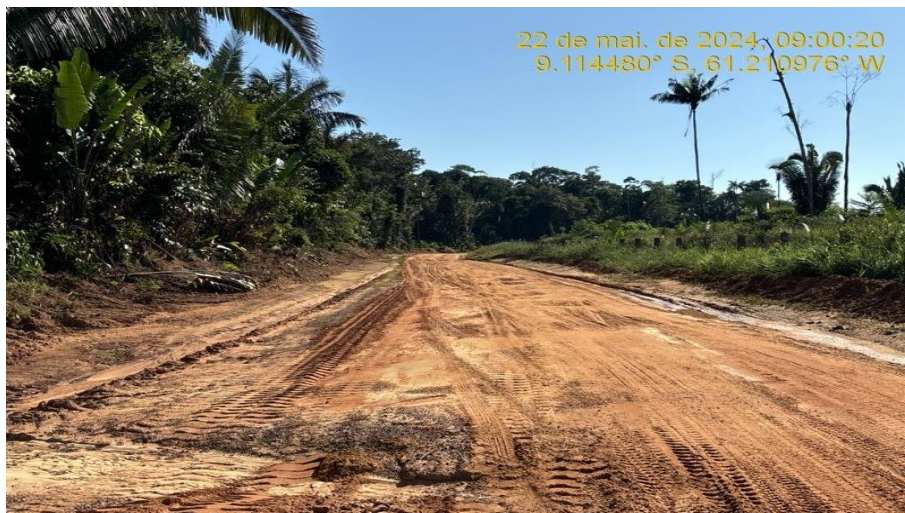
Serviços de Reconformação da plataforma, valeta de drenagem e saída d'água.
