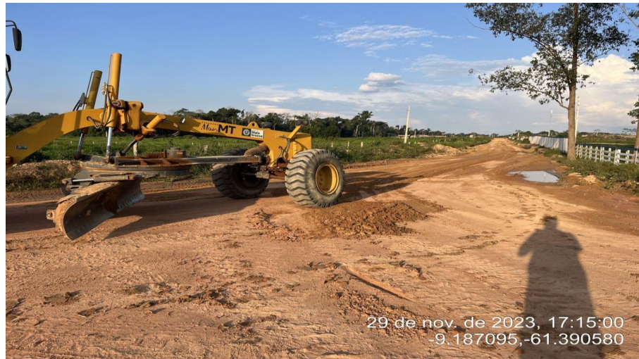
Serviços de Reconformação da plataforma – Fotos fornecidas pela Associação Três Fronteira.
