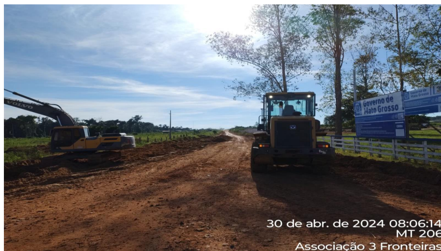
Serviços de Escavação, carga e transporte mat. 1ª cat. – Fotos fornecidas pela Associação Três Fronteira.
