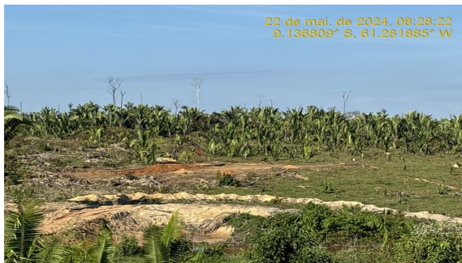
Serviços de escavação, carga e transporte – jazida de cascalho
