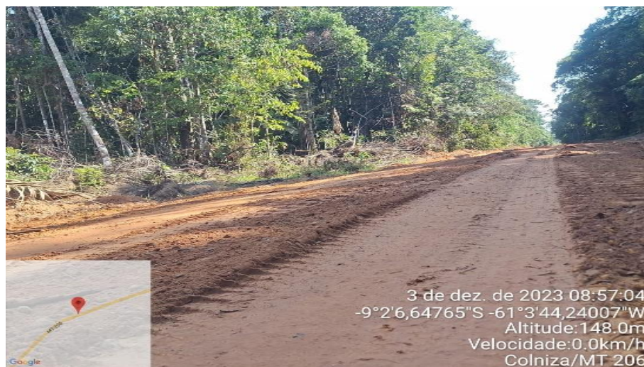
Serviços de Reconformação da plataforma, Recomposição de revestimento primário c/mat. Jaz. – Fotos fornecidas pela Associação Três Fronteira.
