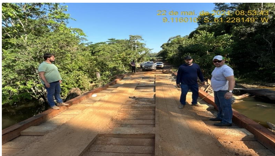
Serviços de Reforma de ponte de madeira (troca de rodeiro, assoalho, trava de rodeiro e guarda rodas).
