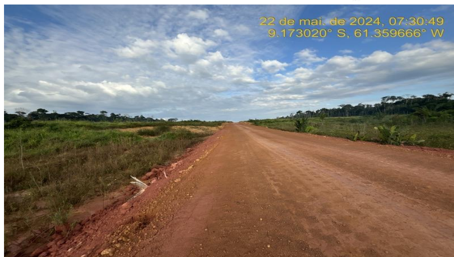
Serviços de Recomposição do Revestimento Primário (encascalhamento) e elevação do Greide.
