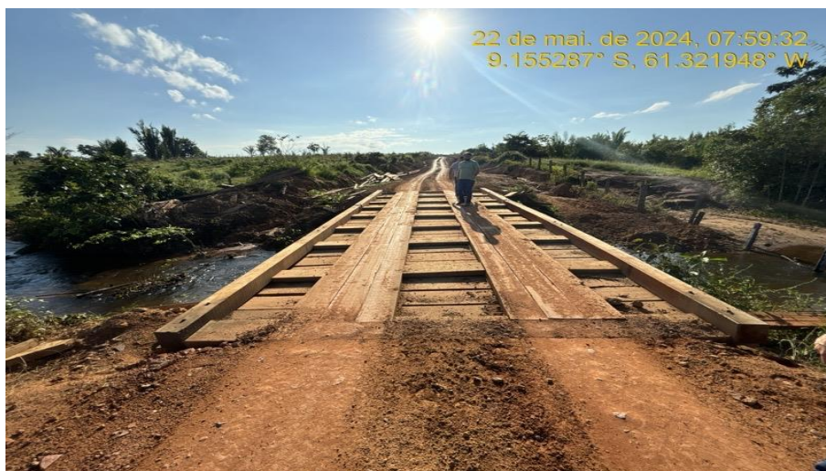
Serviços de Reforma de ponte de madeira (troca de rodeiro, trava de rodeiro, assoalho e guarda rodas).
