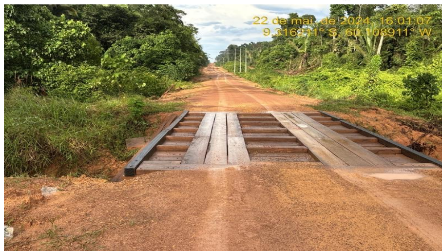
Serviços de Reforma de ponte de madeira (troca de rodeiro, assoalho, trave de rodeiro e guarda rodas).
