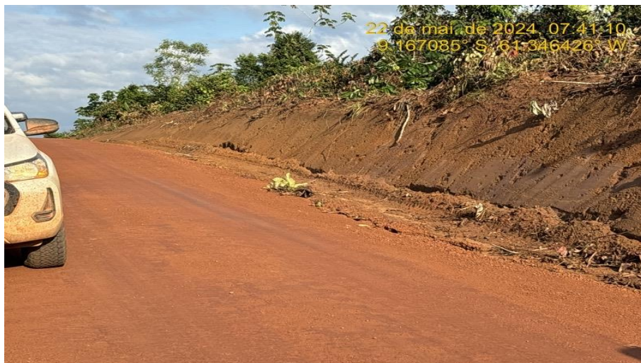
Serviços de Recomposição do Revestimento Primário (encascalhamento), Corte e valeta de drenagem.
