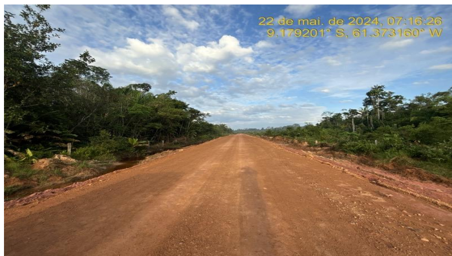
Serviços de Recomposição do Revestimento Primário (encascalhamento).
