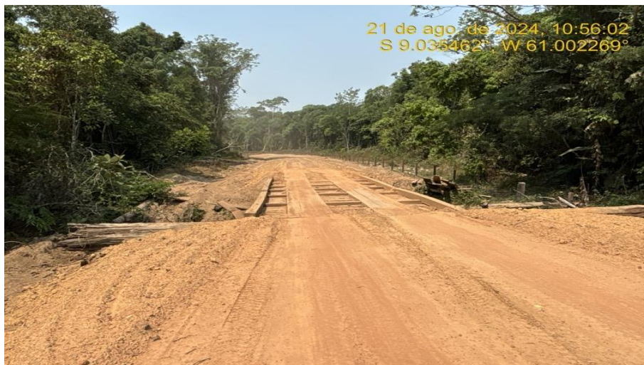
Recomposição do Revestimento Primário – Reforma de ponte de madeira – Rodovia MT-206 (km 121 ao km 297).
