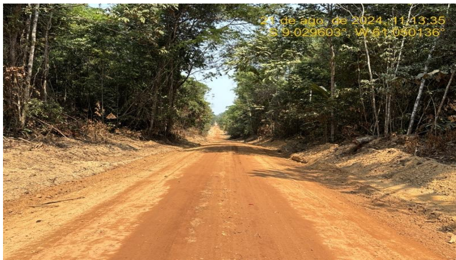
Recomposição do Revestimento Primário – Rodovia MT-206 (km 121 ao km 297).
