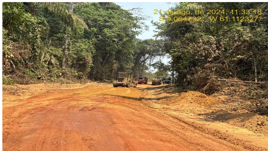
Recomposição do Revestimento Primário – Maquinário trabalhando (Moto niveladora, pipa e caminhão basculante) – Rodovia MT-206 (km 121 ao km 297).
