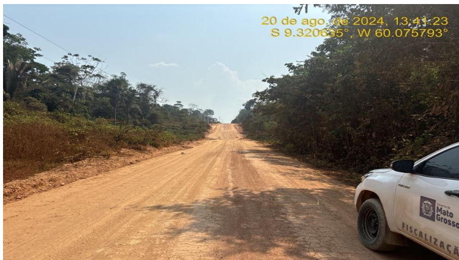
Início do trecho – Recomposição do Revestimento Primário – Rodovia MT-206 (km 121 ao km 297).
