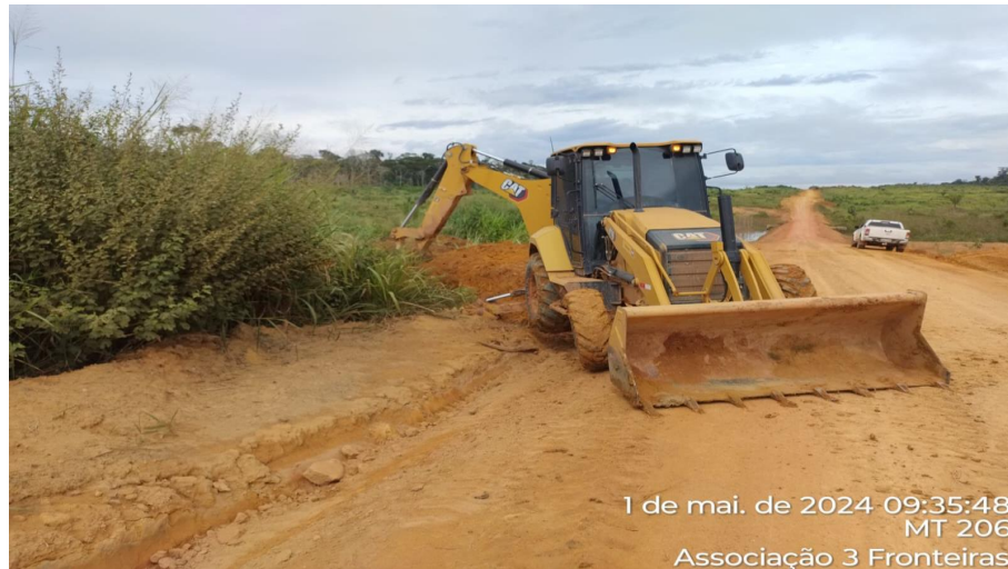
Recomposição do Revestimento Primário – Execução de saída d’água – Rodovia MT-206 (km 121 ao km 297).
