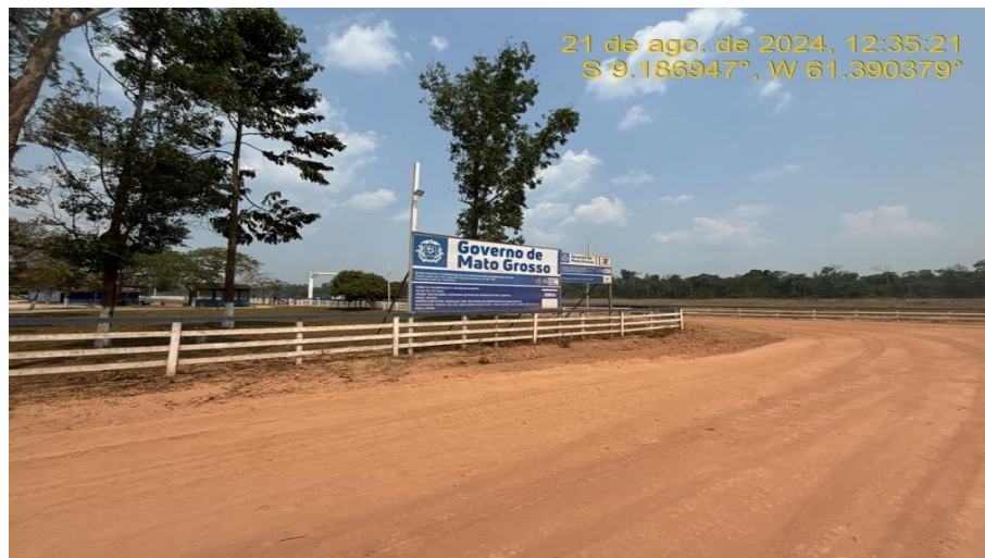
Fim do trecho – Sede da fazenda São Francisco / ECOTECA – Recomposição do Revestimento Primário – Rodovia MT-206 (km 121 ao km 297).
