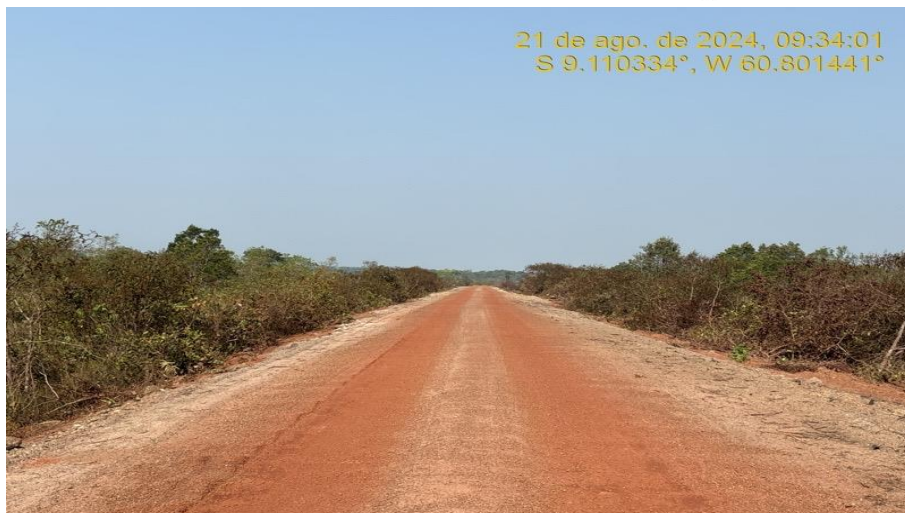
Recomposição do Revestimento Primário – Elevação do Greide – Rodovia MT-206 (km 121 ao km 297).
