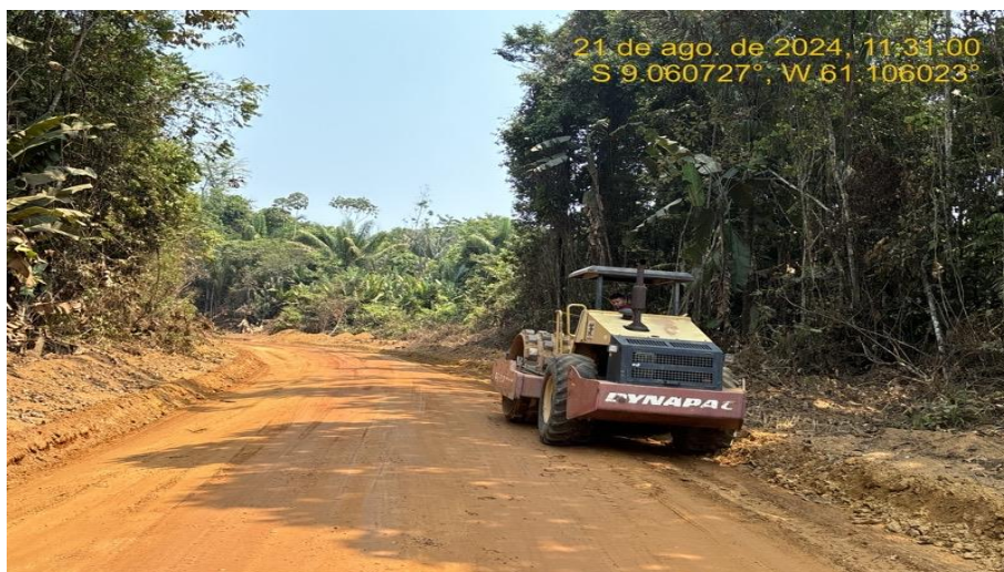
Recomposição do Revestimento Primário – Maquinário trabalhando (Rolo pé de carneiro) – Rodovia MT-206 (km 121 ao km 297).
