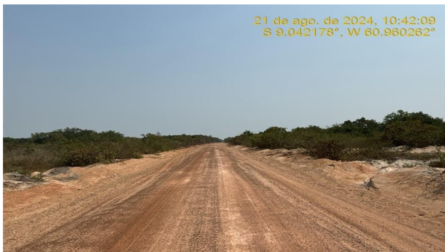
Recomposição do Revestimento Primário – Saída d'água – Rodovia MT-206 (km 121 ao km 297).
