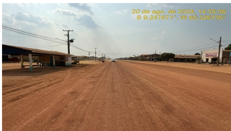
Recomposição do Revestimento Primário (Distrito de Guariba) – Rodovia MT-206 (km 121 ao km 297).
