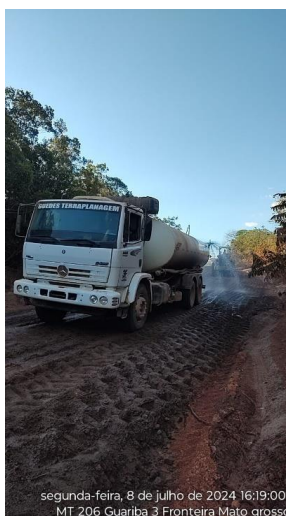
Recomposição do Revestimento Primário – Umedecimento – Compactação – Rodovia MT-206 (km 121 ao km 297).
