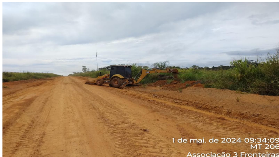
Serviços de Reconformação da plataforma – Execução de saída d'água – Fotos fornecidas pela Associação Três Fronteira.
