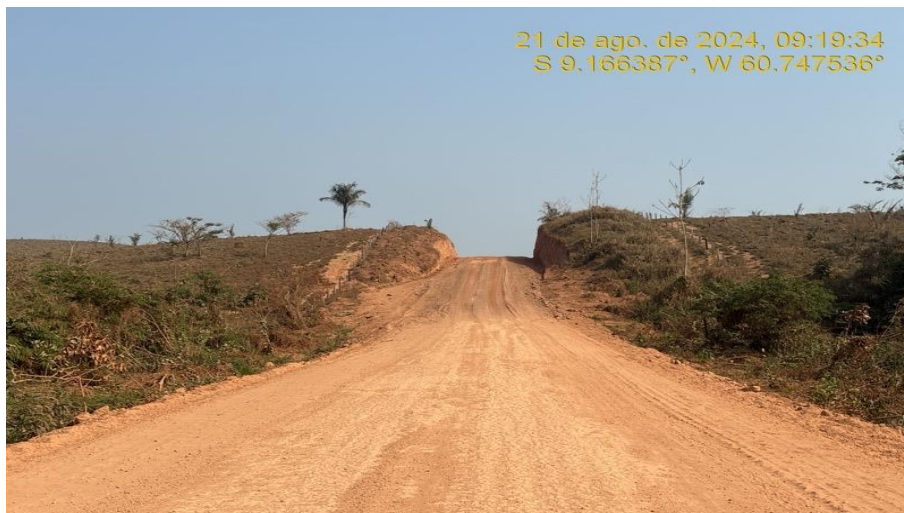
Recomposição do Revestimento Primário – Escavação, carga e transporte de 1ª categoria – Rodovia MT-206 (km 121 ao km 297).
