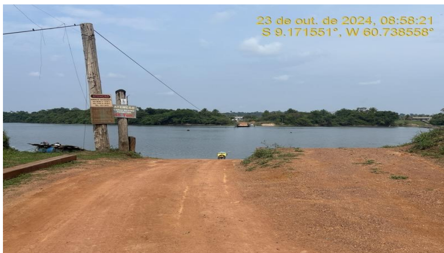
Recomposição do Revestimento Primário – Balsa do rio Roosevelt – Rodovia MT-206 (km 121 ao km 297).
