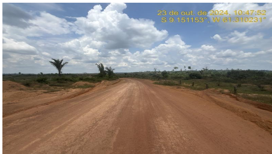
Recomposição do Revestimento Primário – Dispositivo de drenagem (descida d'água) – Rodovia MT-206 (km 121 ao km 297).
