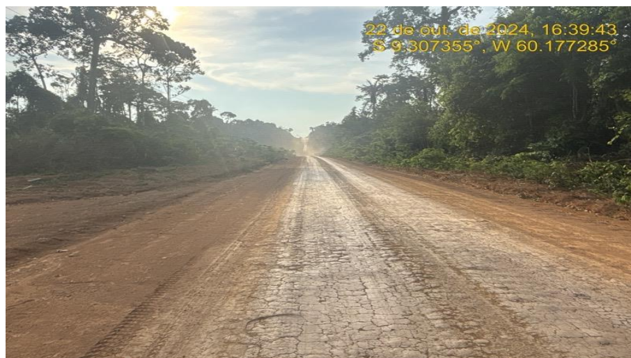
Serviços de Reconformação da plataforma – Rodovia MT-206 (km 121 ao km 297).
