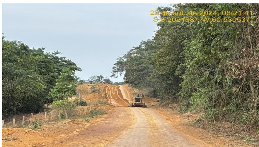
Recomposição do Revestimento Primário – Reconformação da Plataforma da rodovia com motoniveladora em pontos onde apresenta irregularidade (ondulações, corrugações) – Rodovia MT-206 (km 121 ao km 297).
