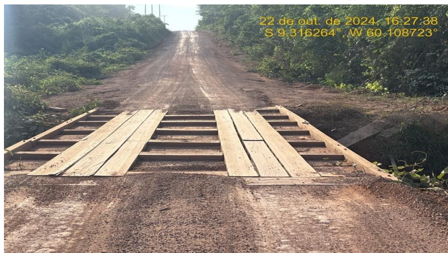
Recomposição do Revestimento Primário – Ponte de madeira reformada – Rodovia MT-206 (km 121 ao km 297).
