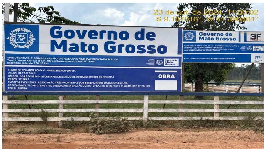
Fim do trecho Fazenda São Francisco – ECOTECA – Placa da Obra – Rodovia MT-206 (km 121 ao km 297).
