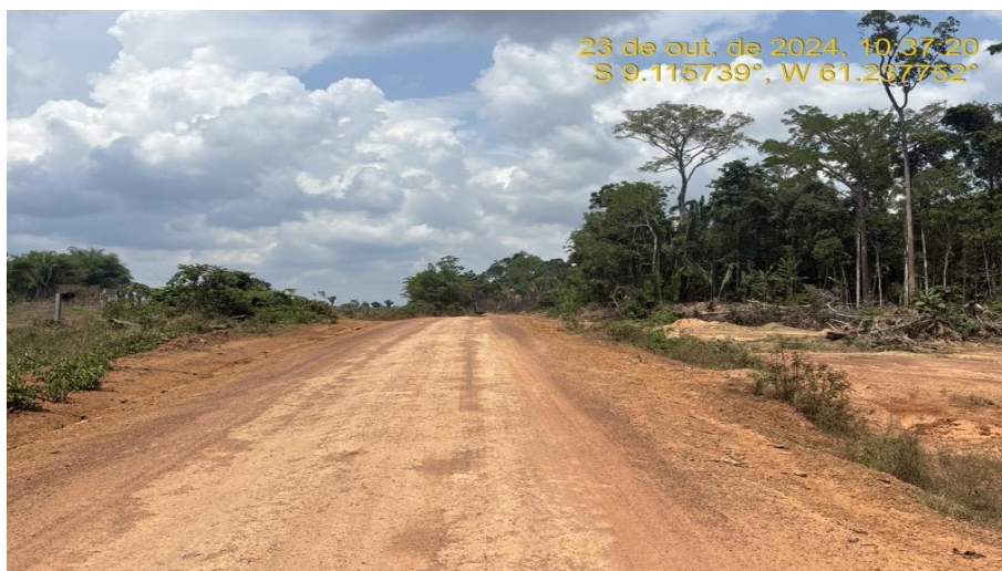
Recomposição do Revestimento Primário – Caixa de Empréstimo lateral – Rodovia MT-206 (km 121 ao km 297).
