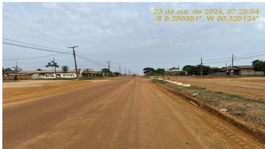
Recomposição do Revestimento Primário – Perímetro Urbano do Distrito de Guariba – Rodovia MT-206 (km 121 ao km 297).
