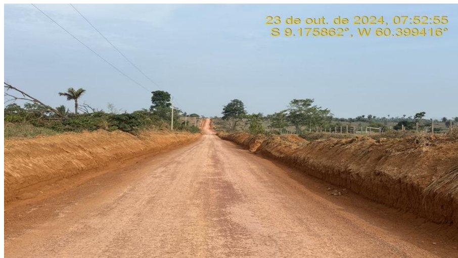
Recomposição do Revestimento Primário – Dispositivos de drenagem (Descida d'água) – Rodovia MT-206 (km 121 ao km 297).
