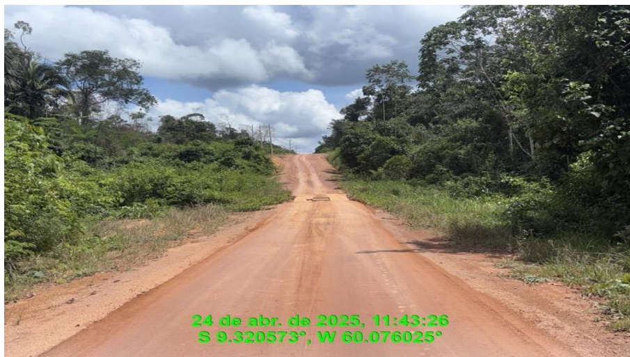
Reconformação da plataforma – Rodovia MT-206 (km 121 ao km 297).
