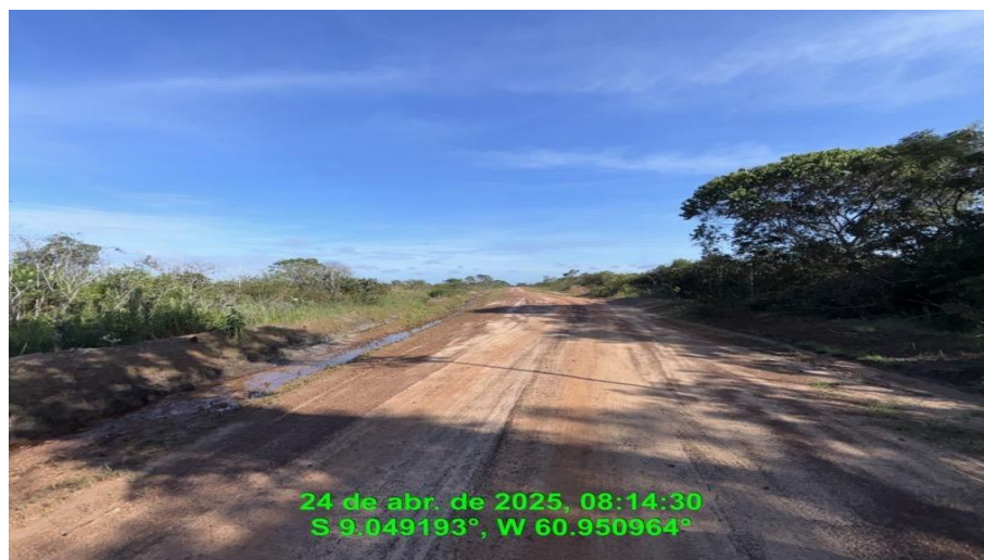
Reconformação da plataforma – Dispositivos de drenagem (Descida d'água) – Rodovia MT-206 (km 121 ao km 297).
